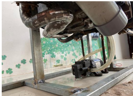
Hình 7. Thi công hệ thống xả khí thải
